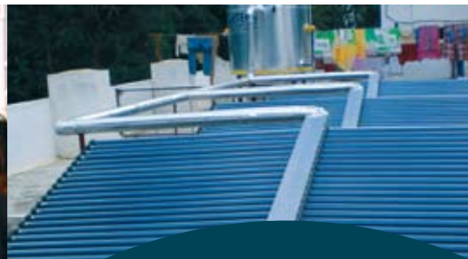
Til venstre: APSAs yrkesskole sørger for god opplæring som gjør jentene til attraktiv arbeidskraft. Over: Soldrevet varmtvannsanlegg på taket.
